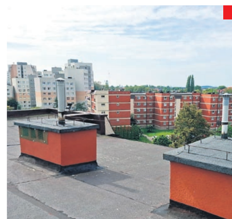
Remont kominów ponad dachem w budynkach przy ul. Spokojnej 41-49.
