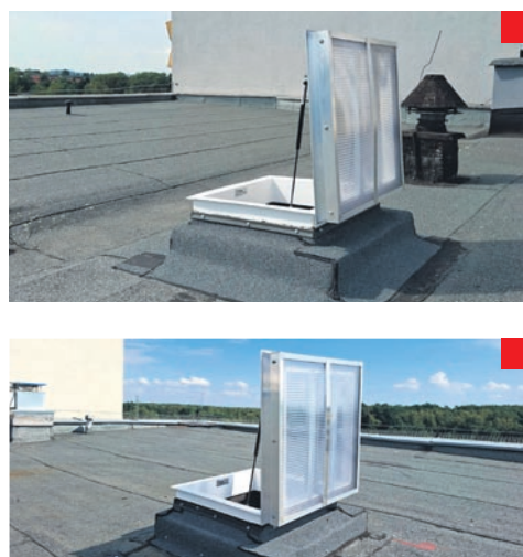
Wymiana wyłazów na dach w budynkach przy ul. Radockiego 132, 162, 214, 268 i Łętowskiego 5B.
