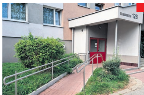
Wykonanie balustrad przy pochylniach dla osób niepełnosprawnych przy ul. Radockiego 62, 128, 216, 222, 244, 246, 270, 272 i 276.
