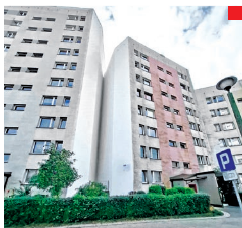
Czyszczenie wraz z malowaniem ścian szczytowych budynków przy ul. Radockiego 82 i 84.
